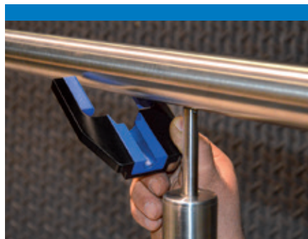
Abführen der Vorrichtung und Fertigstellen der Schweißarbeiten. Effectuez la soudure en continu.
